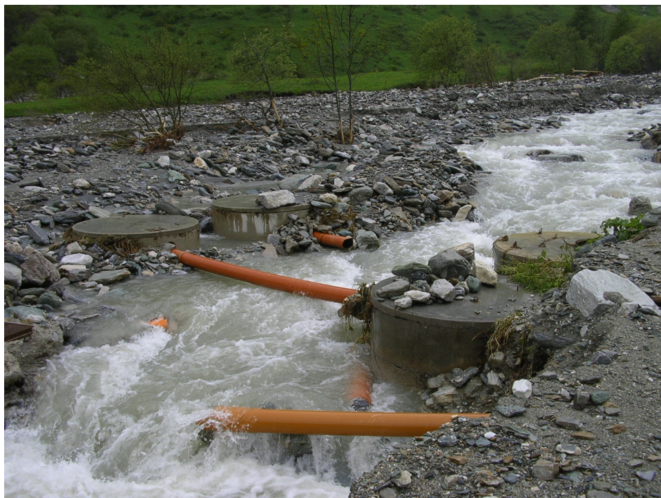
Fig. 5: Vista del depuratore danneggiato dall'alluvione del 2008.
