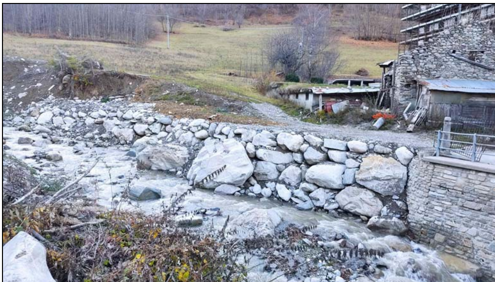
Figura 17 – Vista dalla S.S. n. 20 del tratto di sponda sinistra del Torrente Vermenagna (ora ripristinato con la formazione di una scogliera) in cui è stato asportato un tratto della fognatura proveniente da monte.
