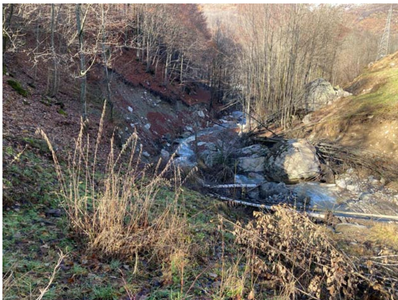
Figura 27 – Vista da monte di un tratto di alveo del Rio Panice a valle di Tetto Corea in cui risulta evidente l'erosione al piede della scarpata sinistra con franamento di parte del versante ed asportazione della fognatura.
