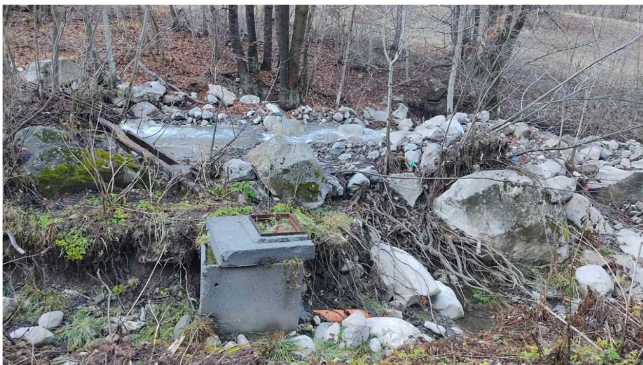
Foto n. 8: Int. n. 2 – Particolare della sponda destra del Torrente Vermenagna a valle della Fraz. Limonetto attualmente in dissesto a seguito degli eventi alluvionali (si noti il pozzetto danneggiato e la condotta fognaria divelta).
