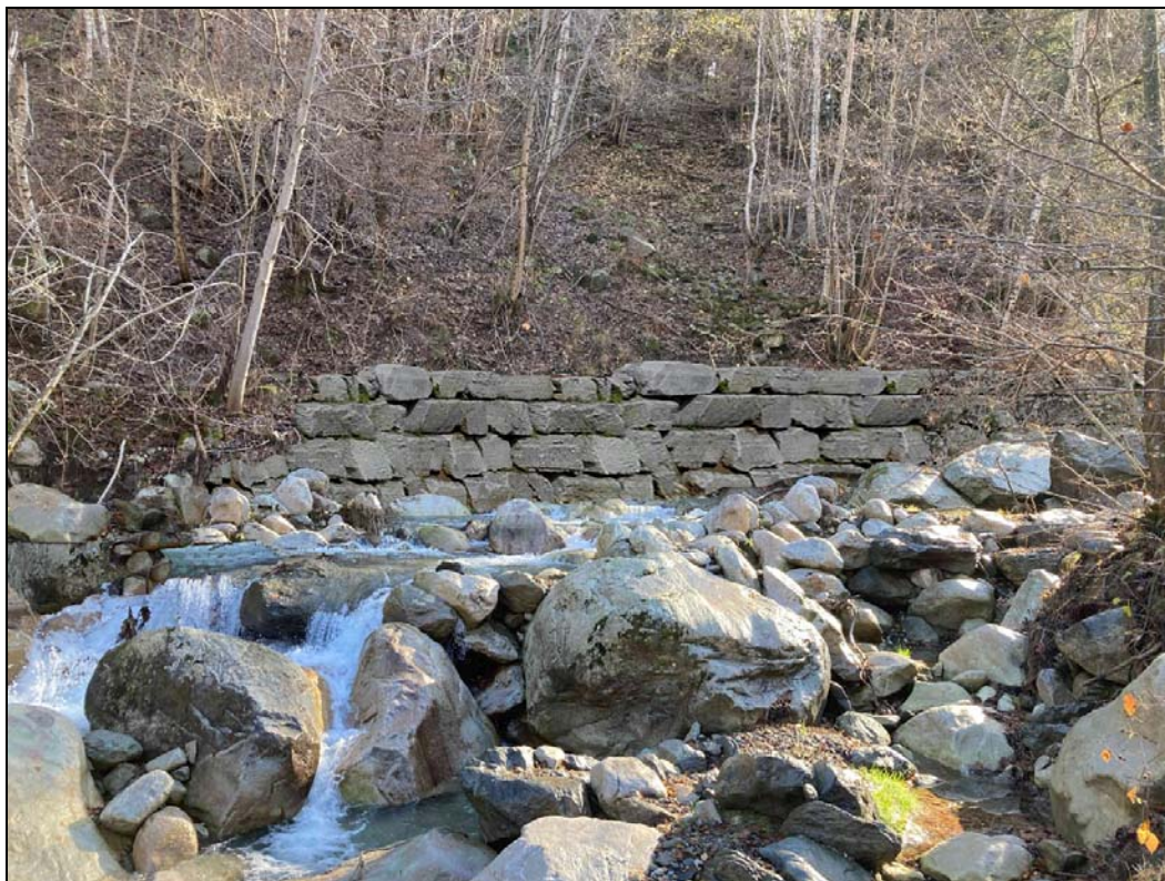
Fotoinserimento 5 – Intervento n. 2 – Località Limonetto: alveo del Torrente Vermenagna nel tratto di valle dove è previsto il ripristino della fognatura e la realizzazione di una difesa in massi di cava in sponda destra (stato in progetto).
