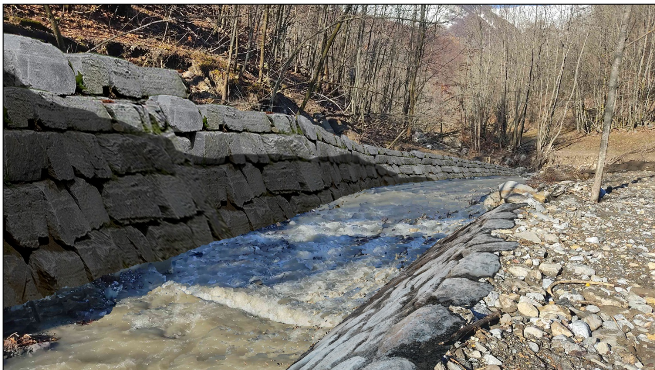
Fotoinserimento 7 – Intervento n. 3 – Località Tetto Corea: alveo del Rio Panice presso l'inizio di monte dove è previsto il ripristino della fognatura e la realizzazione di una difesa in massi di cava in sponda sinistra (stato in progetto).
