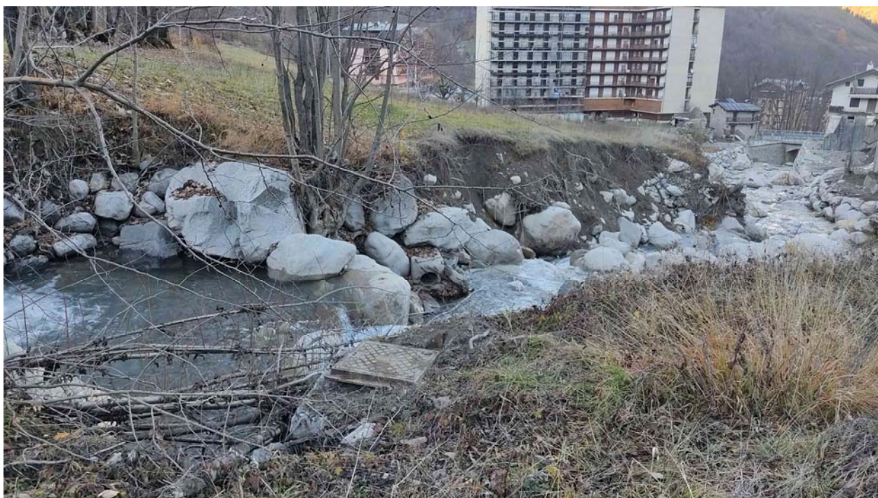
Foto n. 4: Int. n. 1 – Vista dalla sponda destra del tratto di Torrente Vermenagna in cui è stato divelto l'esistente attraversamento fognario in subalveo (si notino nella foto il chiusino del pozzetto, in destra, ed i resti della condotta in alveo).
