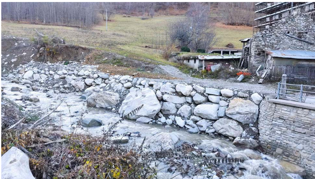
Foto n. 2: Int. n. 1 – Vista verso monte dalla Strada Statale n. 20 del tratto di sponda sinistra del Torrente Vermenagna (ora ripristinato con la formazione di una scogliera) in cui le acque asportarono un tratto della condotta fognaria proveniente da monte.
