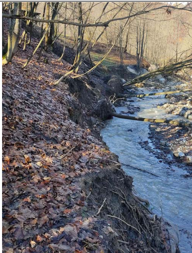
Foto n. 24: Int. n. 3 – Loc. Tetto Corea – Vista verso valle della scarpata in sinistra idrografica del Rio Panice che è stata parzialmente erosa durante gli eventi alluvionali con danneggiamento e/o asportazione dell'esistente condotta fognaria.
