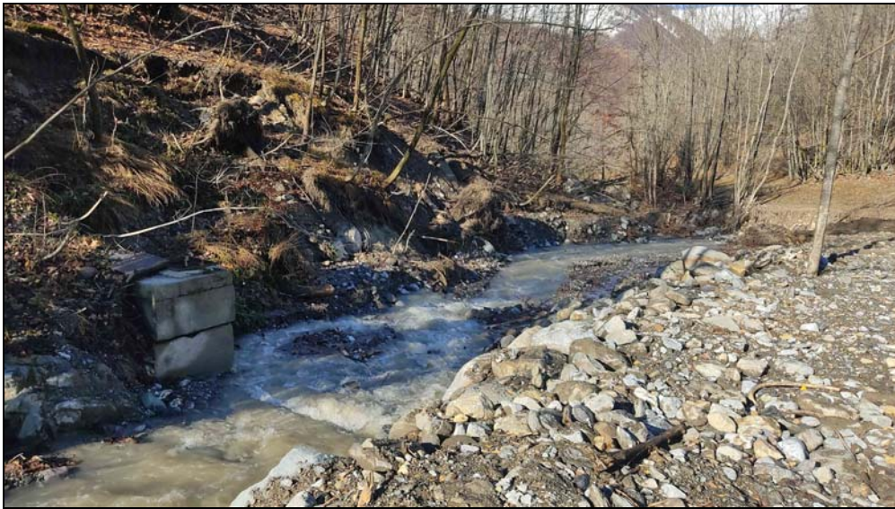
Figura 24 – Vista da monte del tratto di alveo del Rio Panice posto a valle dell'attraversamento fognario in subalveo presso Tetti Cech, si noti l'erosione spondale in sinistra con asportazione della fognatura.
