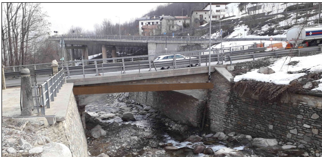
Fotoinserimento 2 – Intervento n. 1 – Località Tetto Mecci: alveo del Torrente Vermenagna presso il previsto attraversamento fognario aereo (stato in progetto).
