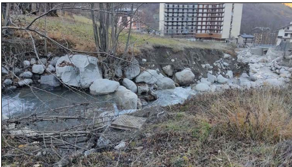
Figura 16 – Vista dalla sponda destra del tratto di Torrente Vermenagna in cui è stato divelto l'esistente attraversamento fognario in subalveo.
