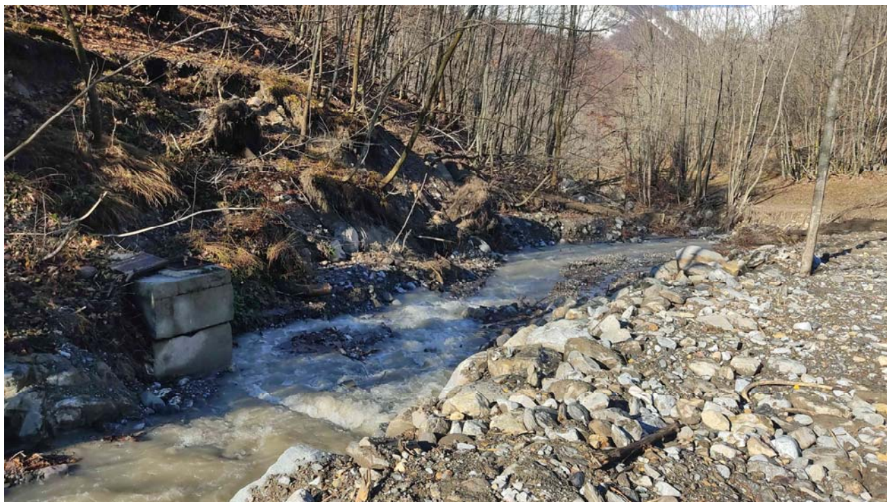
Foto n. 23: Int. n. 3 – Loc. Tetto Corea – Vista verso valle dell'attraversamento in subalveo e del pozzetto esistente lungo il Rio Panice presso Tetti Cech (si noti anche l'erosione in sponda sinistra a valle del pozzetto).
