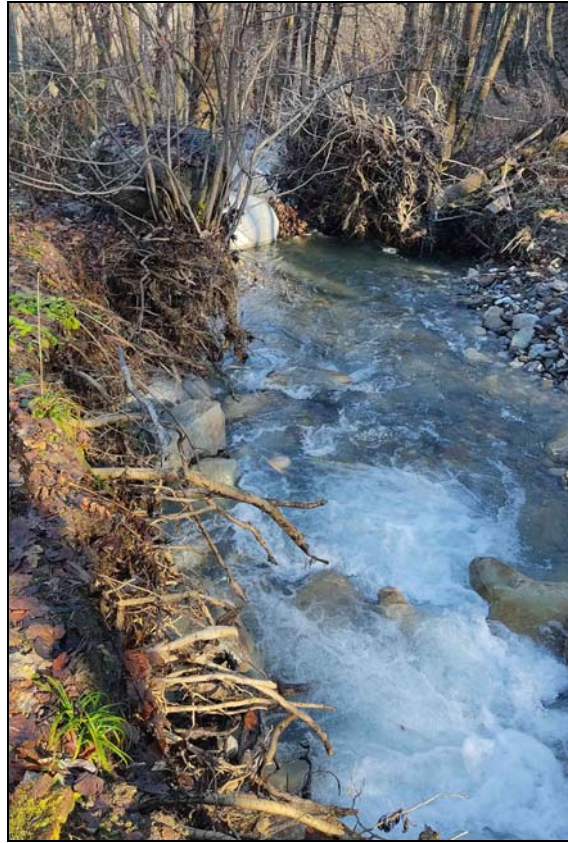
Figura 19 – Vista verso valle della sponda sinistra del Torrente Vermenagna erosa durante gli eventi alluvionali nel tratto posto in corrispondenza del manufatto interrato della vasca scolmatrice della rete fognaria.
