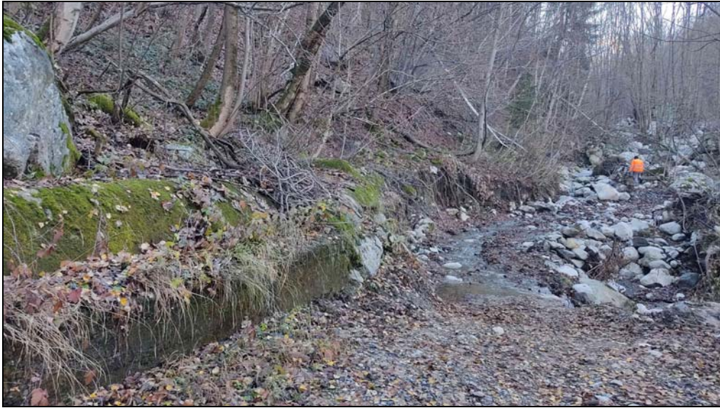
Figura 21 – Vista da valle della scarpata erosa della strada sterrata per Tetti Gigant, in destra del Torrente Vermenagna, erosa nel tratto posto ai piedi della condotta fognaria diretta verso valle.
