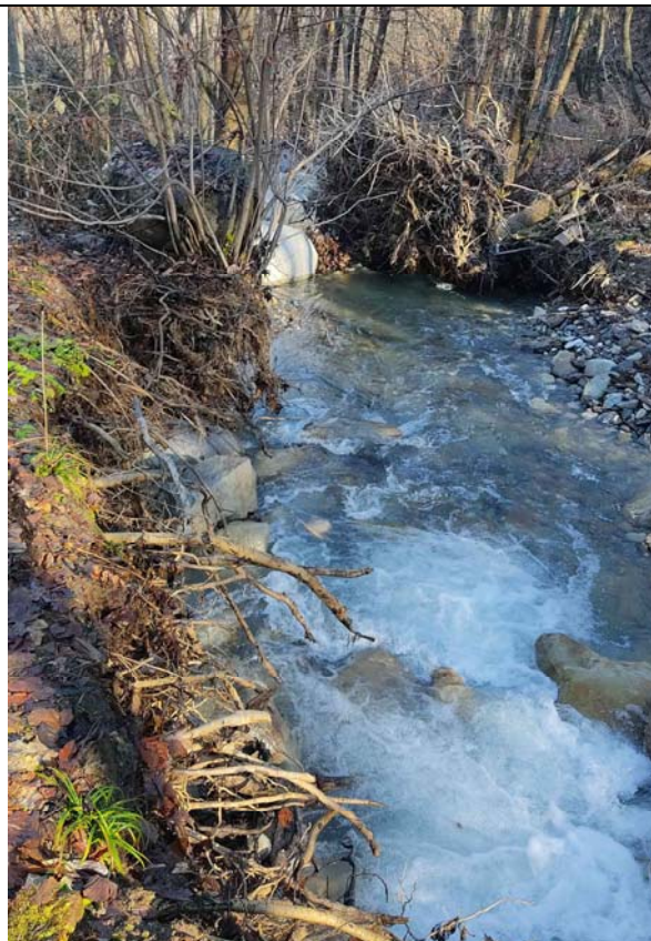
Foto n. 11: Int. n. 2 – Particolare della sponda sinistra del Torrente Vermenagna in corrispondenza della vasca scolmatrice che è stata erosa durante gli eventi alluvionali.
