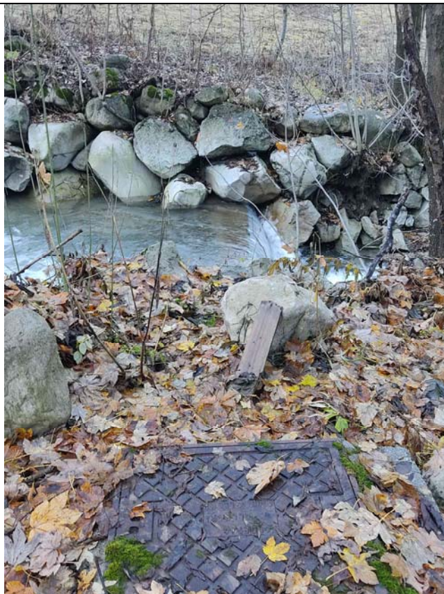
Foto n. 9: Int. n. 2 – Vista dalla sponda destra del Torrente Vermenagna, a valle della Fraz. Limonetto, dell'esistente attraversamento fognario ancora funzionante che verrà consolidato a valle con la posa di massi di cava intasati con cls.
