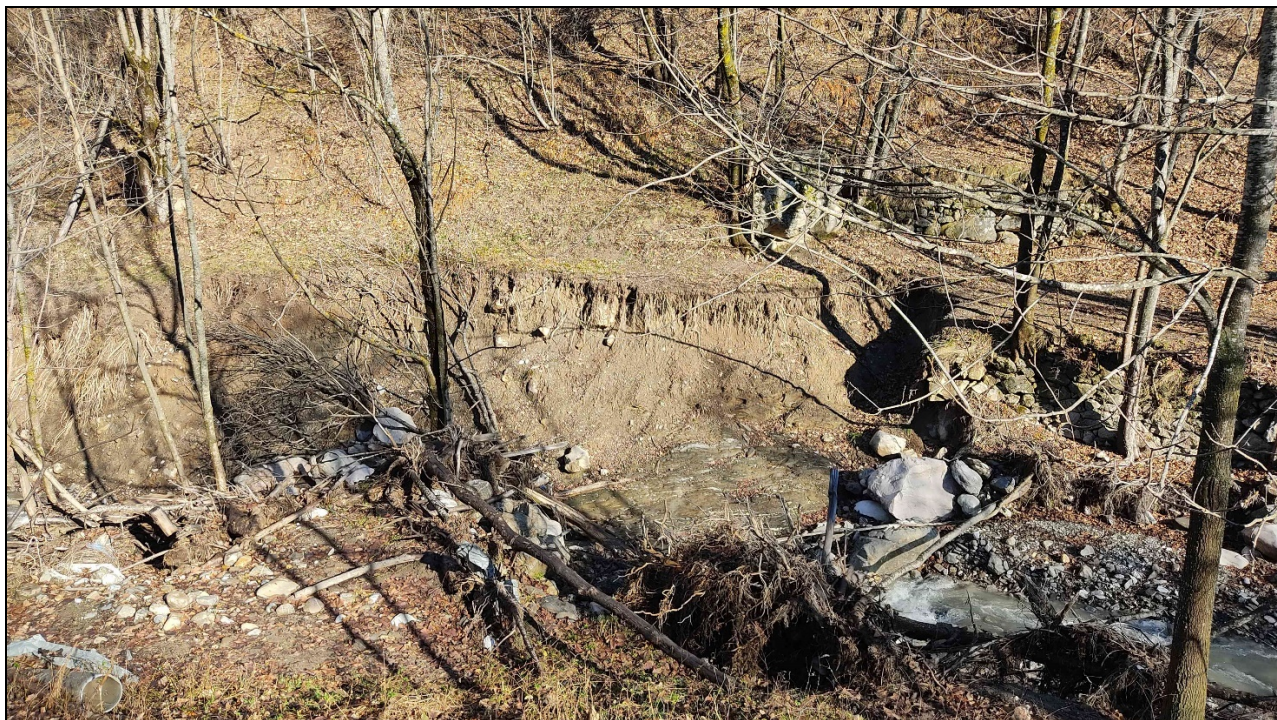
Foto 8 – Intervento n. 3 – Località Tetto Corea: alveo del Rio Panice a valle del previsto attraversamento in subalveo dove si ripristinerà la fognatura e si realizzerà una difesa in massi di cava in sponda destra (stato esistente).
