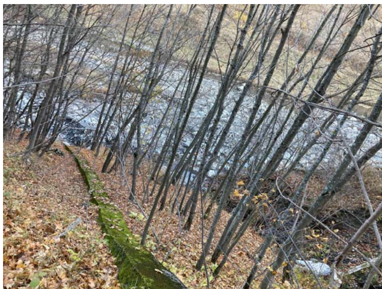
Figura 24 – Vista da monte del versante a valle del piazzale all'imbocco del tunnel del Colle di Tenda con il manufatto in calcestruzzo a protezione della condotta fognaria diretta verso il fondovalle del Vallone della Panice.
