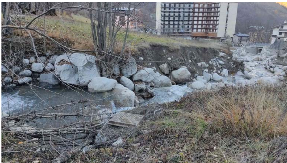
Figura 18 – Vista dalla sponda destra del tratto di Torrente Vermenagna in cui è stato divelto l'esistente attraversamento fognario in subalveo.
