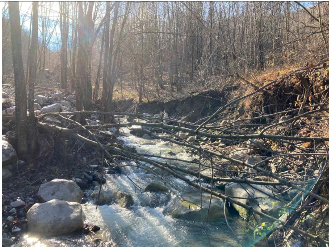
Foto n. 12: Int. n. 2 – Vista verso monte del tratto di alveo del Torrente Vermenagna con la sponda sinistra in erosione e la parziale asportazione della condotta fognaria (intervento di valle a monte della strada per Tetti Gigant).
