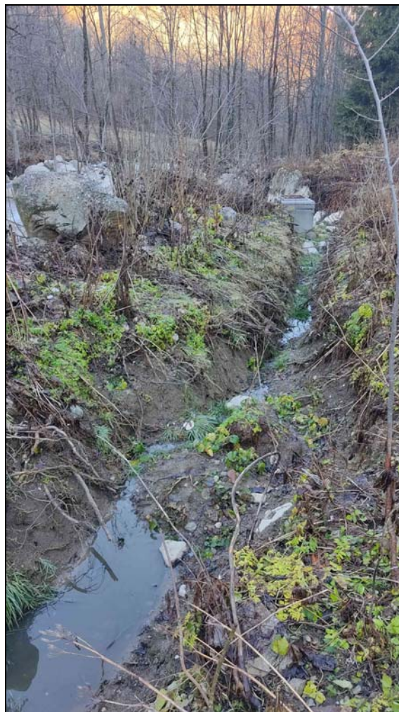
Figura 18 – Vista verso valle della sponda destra del Torrente Vermenagna subito a valle della Loc. Limonetto attualmente in dissesto dove è stato asportato un tratto della fognatura proveniente da monte.
