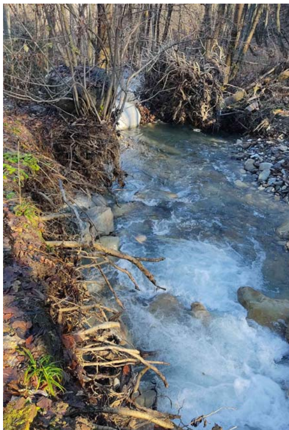
Figura 21 – Vista verso valle della sponda sinistra del Torrente Vermenagna erosa durante gli eventi alluvionali nel tratto posto in corrispondenza del manufatto interrato della vasca scolmatrice della rete fognaria.
