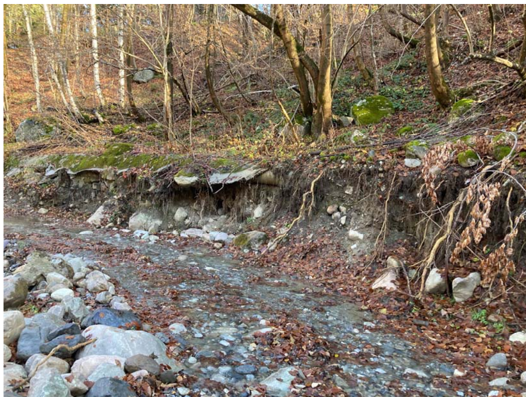
Foto n. 16: Int. n. 2 – Particolare dell'erosione della scarpata stradale della pista di accesso a Tetti Gigant (si noti la condotta fognaria esistente che è stata parzialmente scalzata, anche se ancora funzionante).
