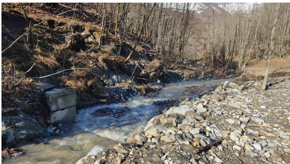
Figura 26 – Vista da monte del tratto di alveo del Rio Panice posto a valle dell'attraversamento fognario in subalveo presso Tetti Cech, si noti l'erosione spondale in sinistra con asportazione della fognatura.
