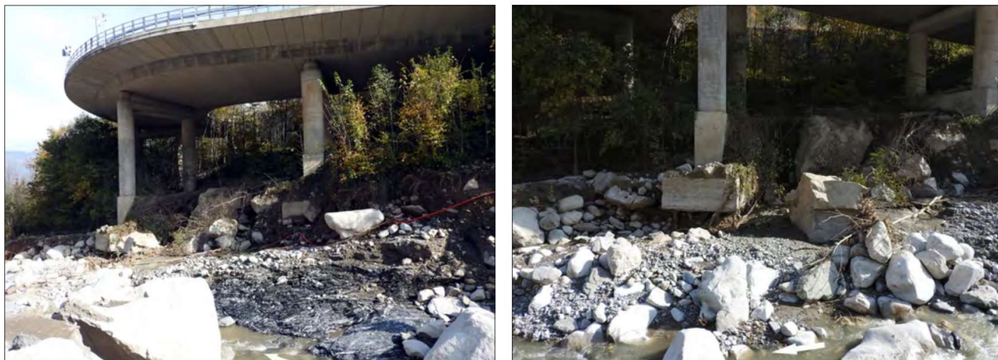
Foto di repertorio: vistose erosioni lungo le sponde del T. Vermenagna, poco a valle dell'immissione del Rio Panice e del nucleo di Tetti Mecci, a danno della stabilità di un pilastro di sostegno della strada statale n. 20 ; a destra il dettaglio dell'erosione alla base del pilone (Fonte geologia dell'Ambiente, Suppl. 4/2021).
