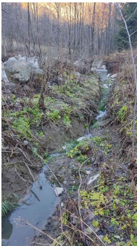
Figura 20 – Vista verso valle della sponda destra del Torrente Vermenagna subito a valle della Loc. Limonetto attualmente in dissesto dove è stato asportato un tratto della fognatura proveniente da monte.
