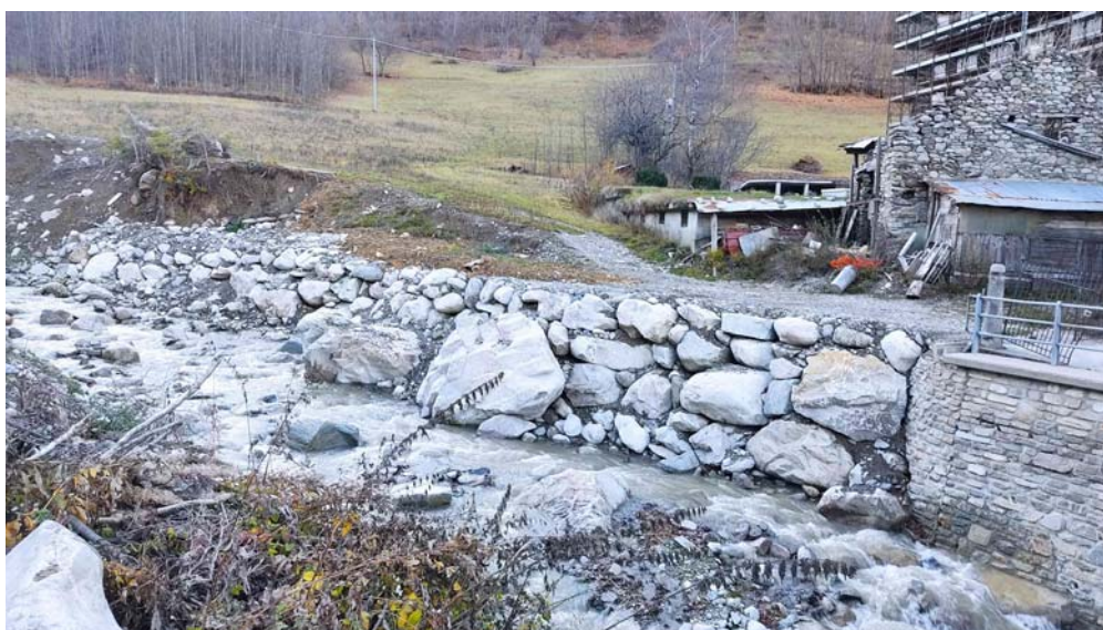
Figura 19 – Vista dalla S.S. n. 20 del tratto di sponda sinistra del Torrente Vermenagna (ora ripristinato con la formazione di una scogliera) in cui è stato asportato un tratto della fognatura proveniente da monte.
