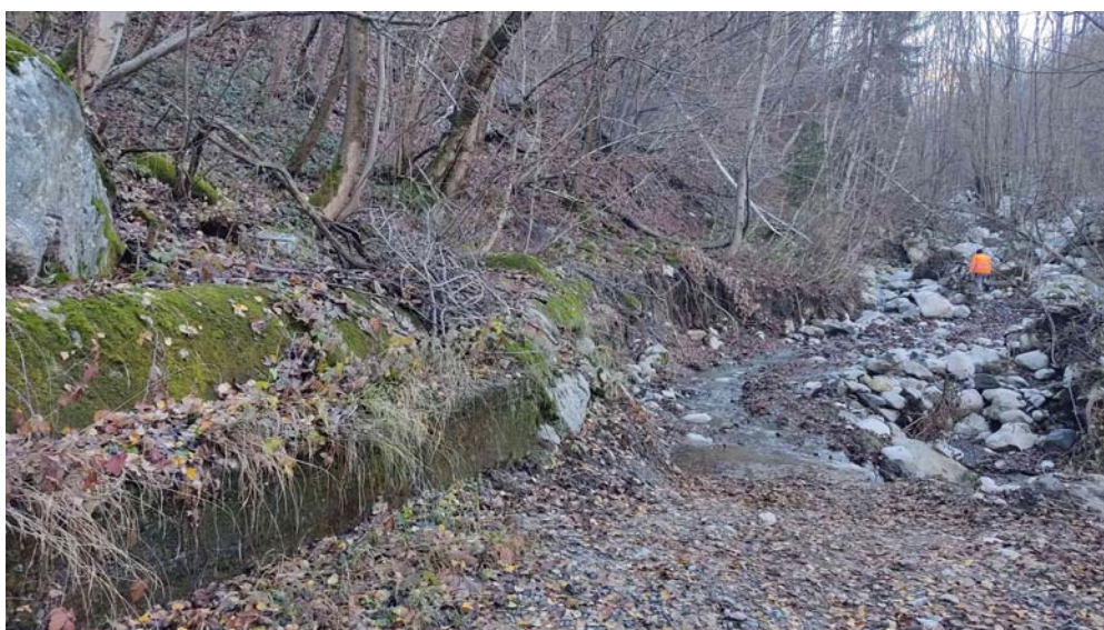
Figura 23 – Vista da valle della scarpata erosa della strada sterrata per Tetti Gigant, in destra del Torrente Vermenagna, erosa nel tratto posto ai piedi della condotta fognaria diretta verso valle.
