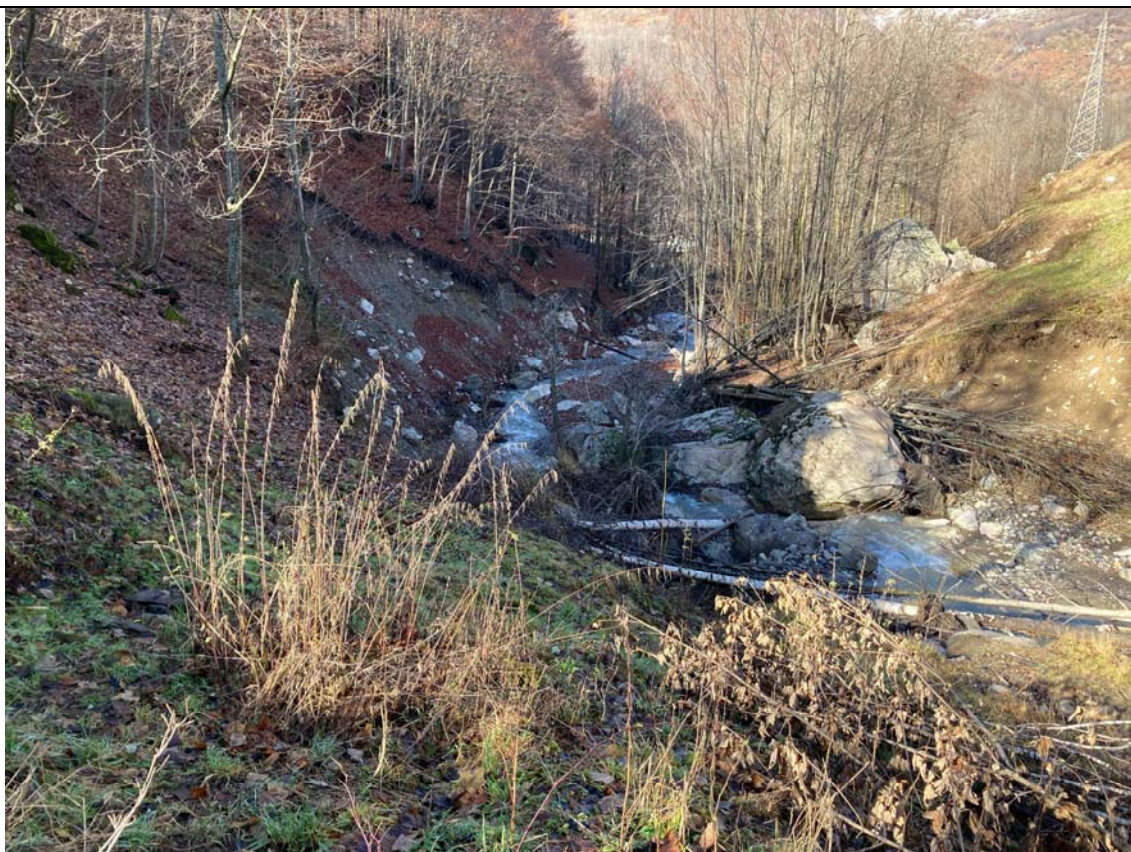
Foto n. 27: Int. n. 3 – Loc. Tetto Corea – Vista verso valle delle estese erosioni del versante in sinistra idrografica del Rio Panice nel tratto in è stata completamente divelta la condotta fognaria.
