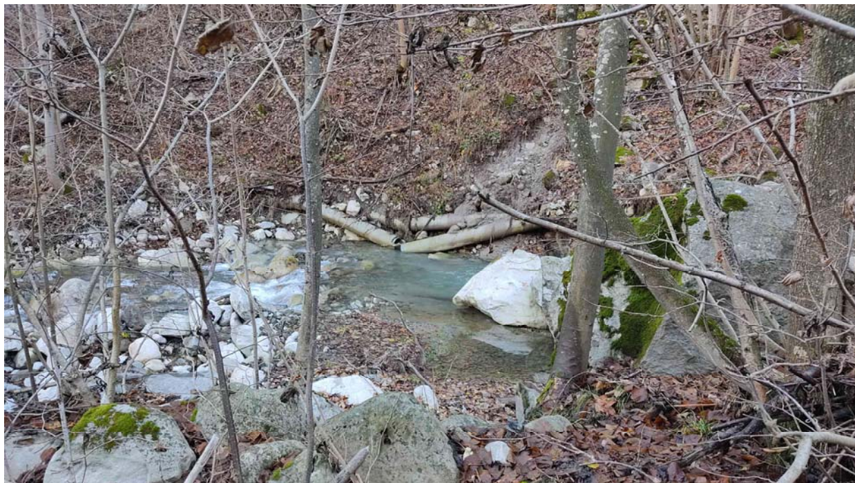
Foto n. 14: Int. n. 2 – Vista del tratto di alveo del Torrente Vermenagna con la sponda destra in erosione e la parziale asportazione della condotta fognaria (intervento di valle a monte della strada per Tetti Gigant).
