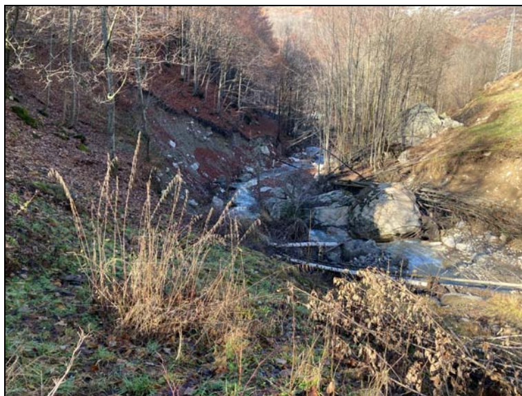
Figura 25 – Vista da monte di un tratto di alveo del Rio Panice a valle di Tetto Corea in cui risulta evidente l'erosione al piede della scarpata sinistra con franamento di parte del versante ed asportazione della fognatura.
