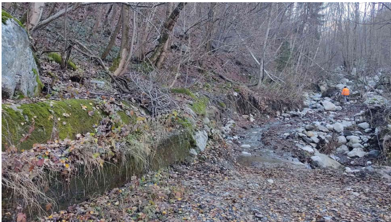
Foto n. 15: Int. n. 2 – Vista dalla strada per Tetti Gigant del tratto di scarpata eroso dalle acque del Torrente Vermenagna lungo la condotta fognaria esistente (che non è stata interrotta).
